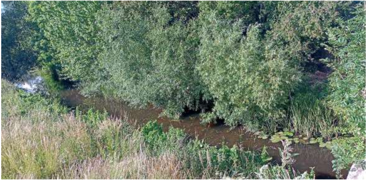
Figur 3: Vårby Å ved broen over Slagelsevej nedstrøms med flere piletræ langs brink.
