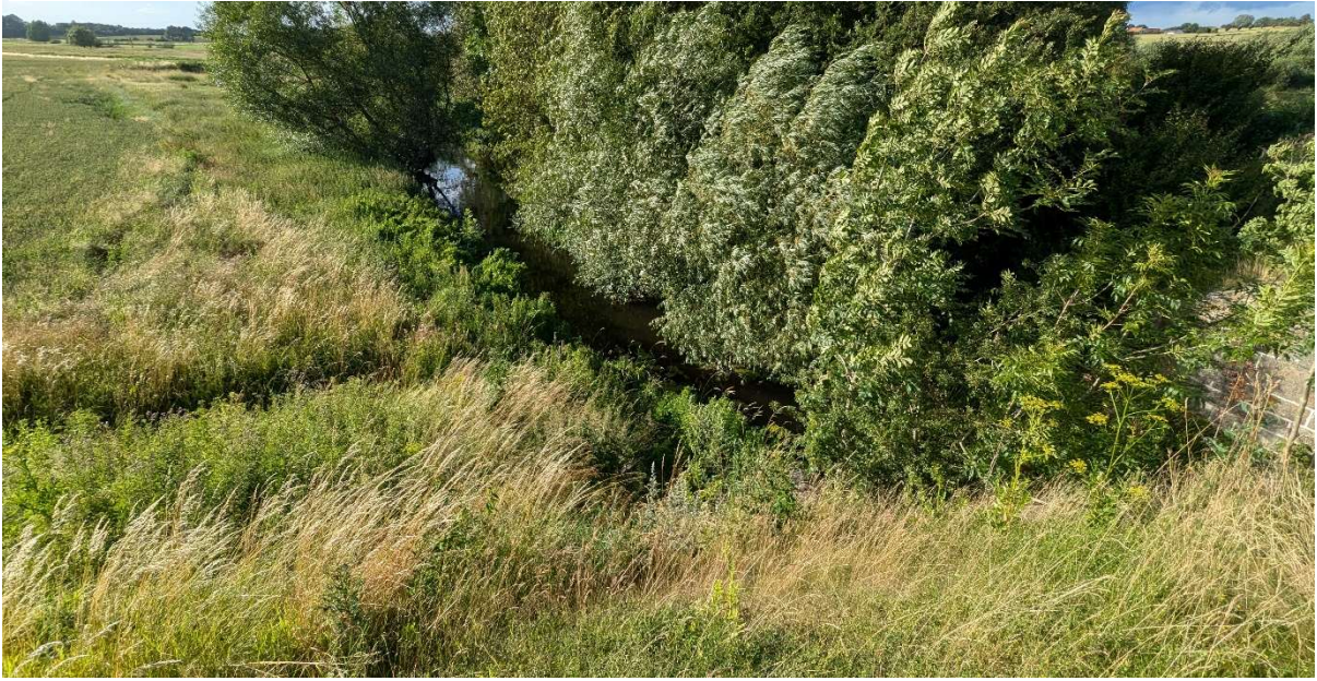
Vårby Å ved broen under Slagelse Landevej. Grene fra piletræer hænger ned i vandoverfladen og opstemmer vandet.
